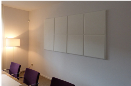
Basotect® tegels van 600 x 600 x 50mm in facet gesneden, doormiddel van lijm op de muur geplaatst.
